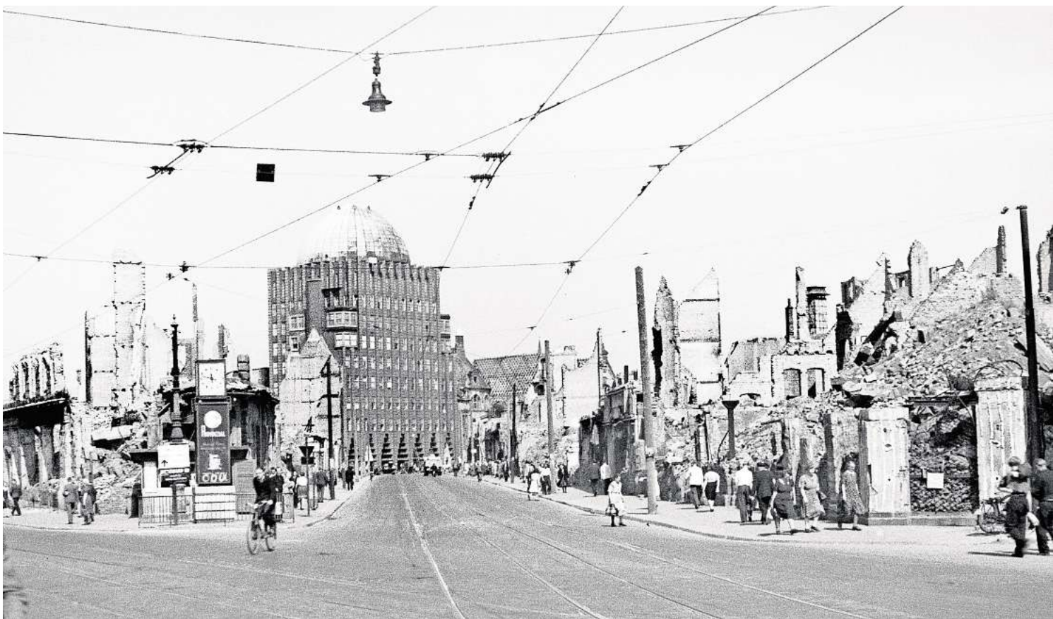
Ein Bild der Zerstörung: Rund um das Anzeiger-Hochhaus lagen nach 1945 weite Teile Hannovers in Trümmern. Foto: Historisches MuseumHannover
