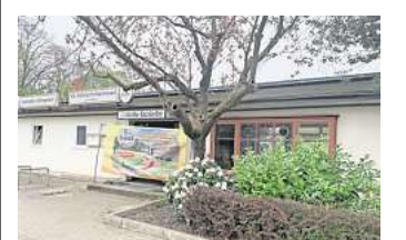
Die Gaststätte 11 A des VfL Eintracht wird grundlegend saniert. Foto: VfL Eintracht
