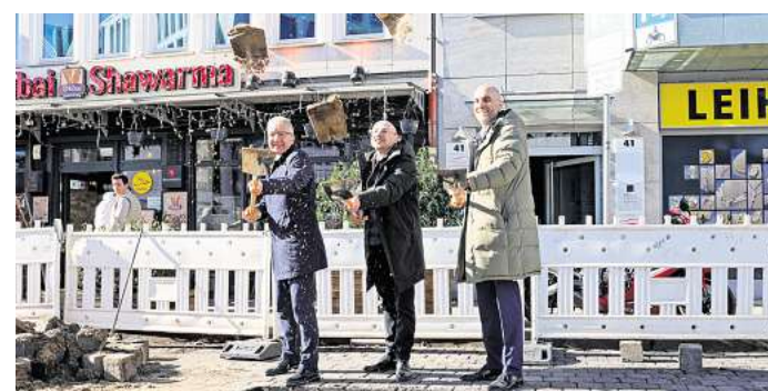
Mit jahrelanger Verspätung setzte die Stadt den ersten Spatenstich für den neuen Steintorplatz. Baudezernent Thomas Vielhaber (links), Architekt Stefan Grieger, Belit Onay (rechts) sind eifrig am schaufeln. Fotos (2): Ilona Hottmann
