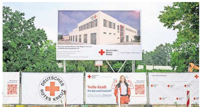
Soll Ende 2026 fertig sein: Das DRK bringt an der Zeißstraße 79 eine Rettungswache, die Verwaltung und ein Bevölkerungsschutzzentrum unter ein Dach. Foto: Jonas Dengler
