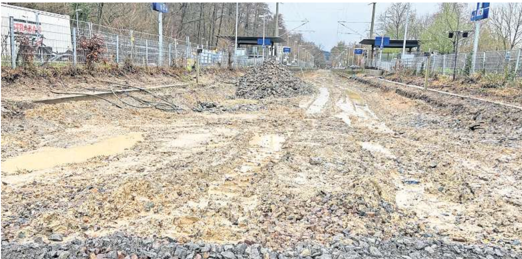
Tiefe Furchen: Auf diesem matschigen Boden kommen die schweren Baumaschinen nicht vorwärts. Eine Baustraße aus Kunststoffmatten soll nun helfen. Foto: Jennifer Krebs
