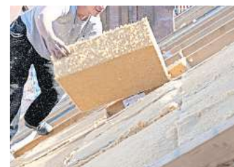
Holzfaser-Dämmstoffe eignen sich sehr gut zur Schalldämmung. Foto: HLC/Steico
