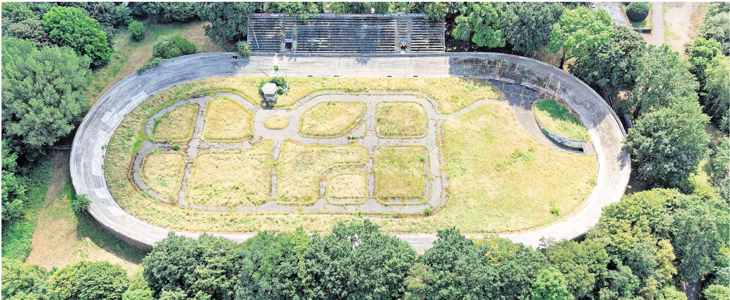
Verfällt immer mehr: Die 1965 eröffnete und 2017 geschlossene Radrennbahn in Wülfel. Sie hatte eine Länge von 333 Metern.
