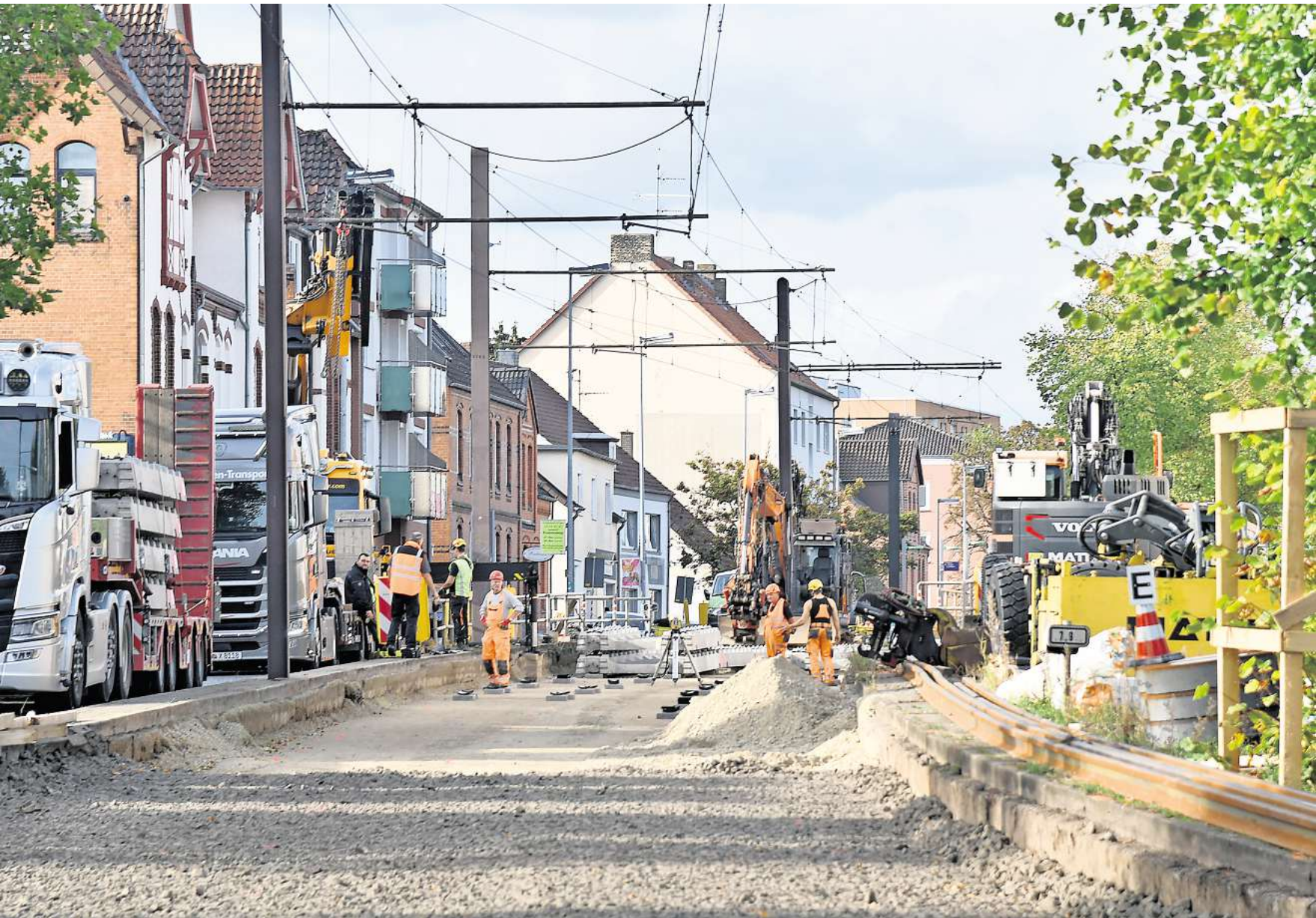
Wie ein großer Sandkasten: In Höhe der Einmündung Am Brocksberg müssen noch die Gleise verlegt werden. Foto: Stephanie Zern
