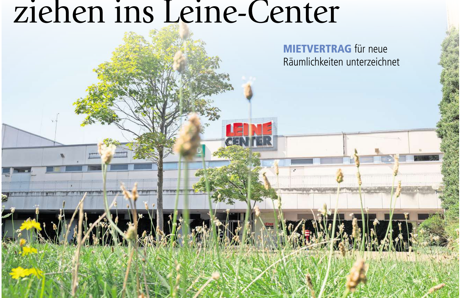
Beherrbergt ab 2027 das Laatzen Bürgerbüro und die Stadtbücherei: das Leine-Center.
