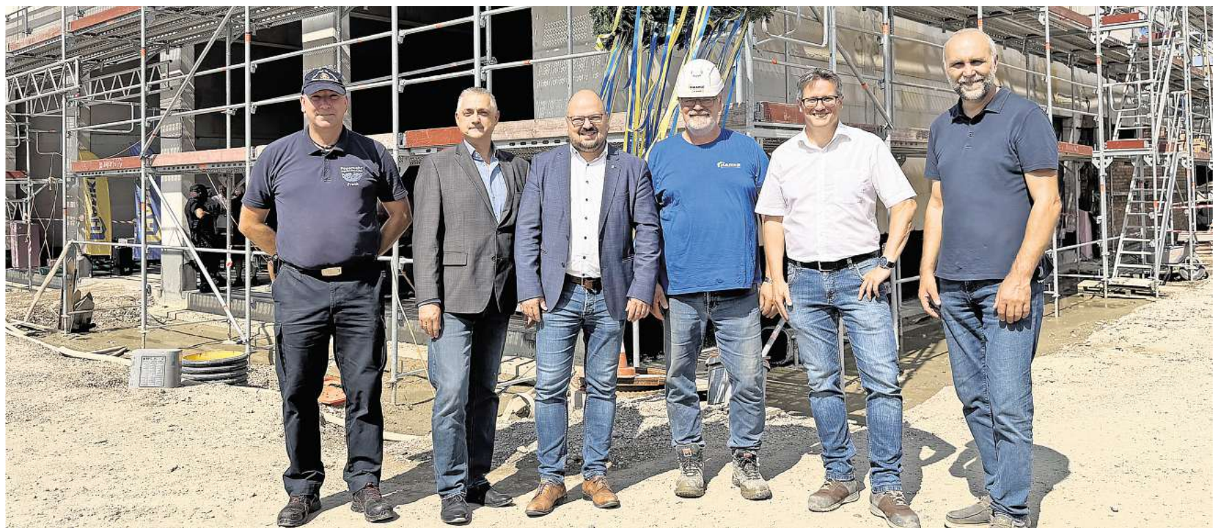
Der Rohbau steht: Beim Richtfest feiern Ortsbrandmeister Frank Bezdiak (von links), Olaf Küpper, Geschäftsführer der Hanke Bau- und Projektentwicklungs GmbH, Bürgermeister Kai Eggert, Polier Markus Schmidt, Projektleiter Stefan Radke von Hanke Bau sowie Steffen Lauterbach von der arc architekturconcept GmbH den planmäßigen Baufortschritt.
