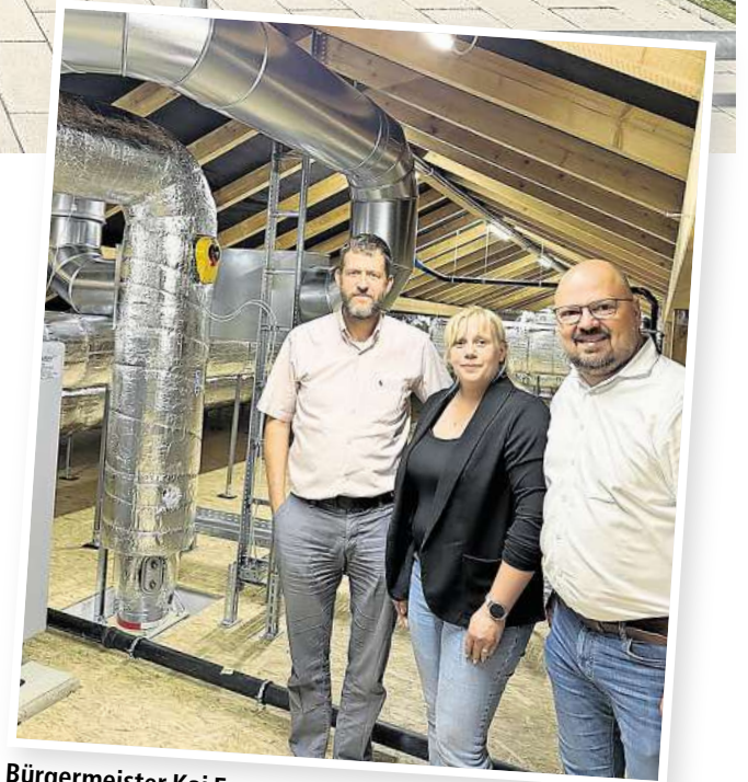
Bürgermeister Kai Eggert (r.) hat in Begleitung von Stadtrat Hauke Schröder und Bau-Fachbereichsleiterin Jessica Kau-Ben das sanierte Dachgeschoss des Grundschulneubaus in Ingeln-Oesselse besichtigt. Foto: Stadt Laatzen
