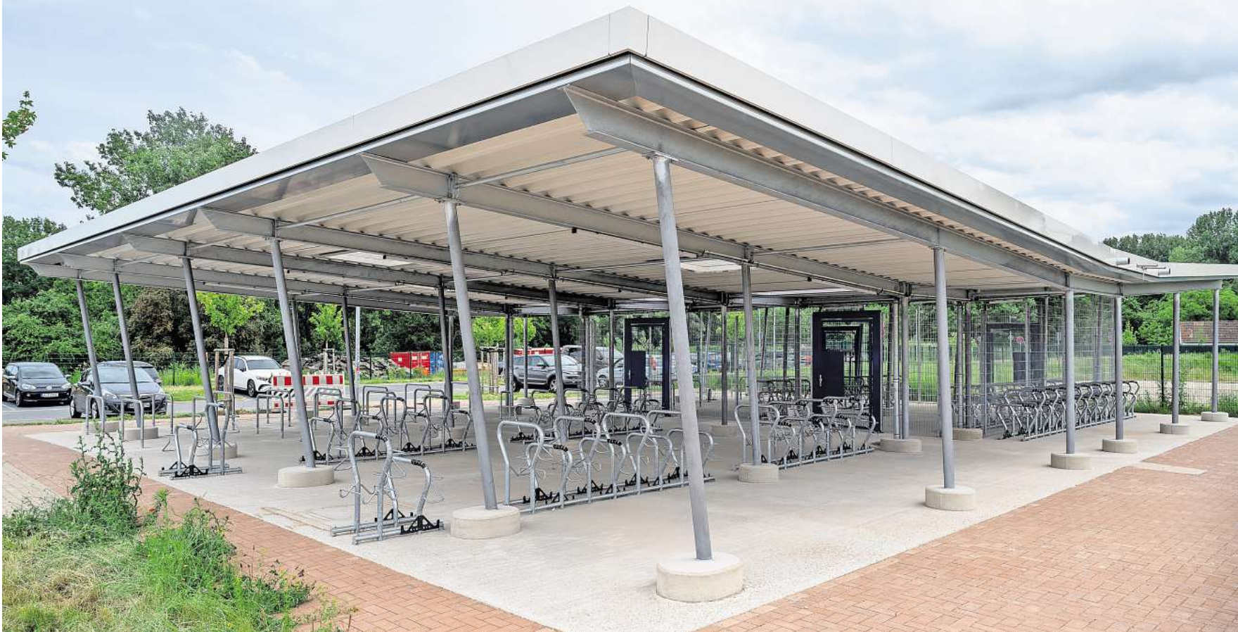
Die Bike-and-ride-Anlage am Endpunkt der Stadtbahnlinie 13 in Hemmingen-Westerfeld ist frei zugänglich.
