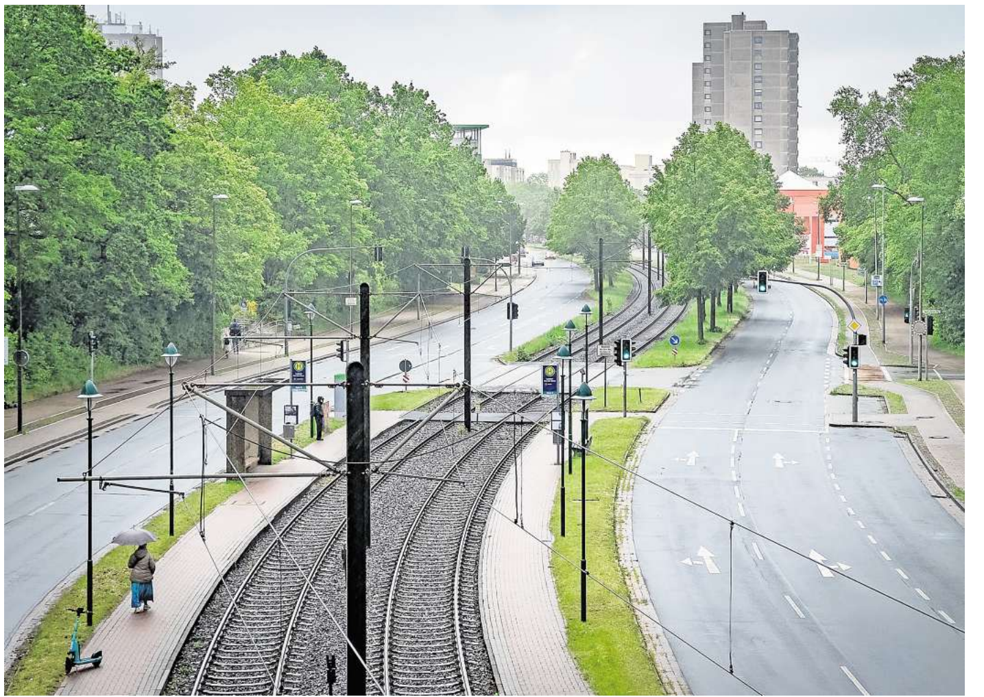
Im Zuge des Neubaus der Hochbahnsteige an der Haltestelle Laatzen/Park der Sinne sollen die Linksabbiegepeile für Autofahrer, die aus Richtung Alt-Laatzen kommen (vorn im Bild), entfernt werden. Die Abbiegespur für Autofahrer, die aus Laatzen-Mitte kommend in den St.-Florian-Weg einbiegen wollen, bleiben hingegen erhalten.
