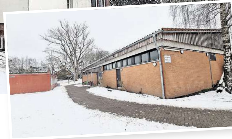
Neubau geplant: Die von Grundschule und Kita genutzte Turnhalle - hier neben den "Schlösschen genannten provisorischen Klassenzimmern - soll einer neuen Mehrzweckhalle weichen. Fotos (2): Johannes Dorndorf
