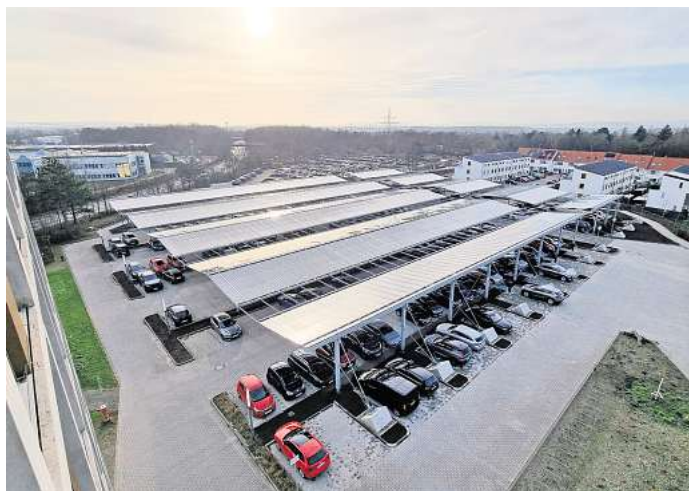
Einzigartige Konstruktion: 1752 Solarmodule überspannen neuerdings 300 der Parkplätze an der Deutschen Rentenversicherung. Fotos: Johannes Dorndorf
