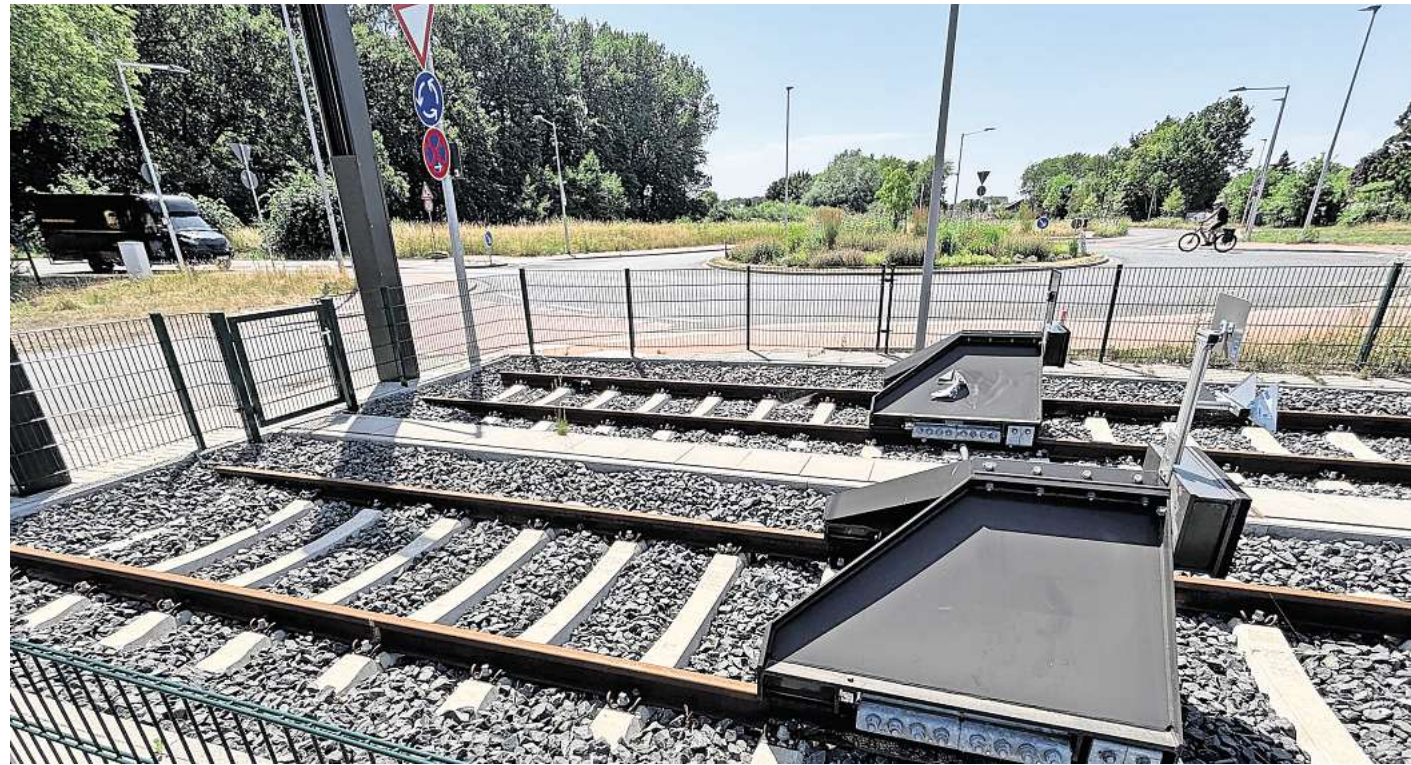
Linie 13: Zurzeit enden die Schienen der Stadtbahn am Kreisell Göttinger Landstraße.
