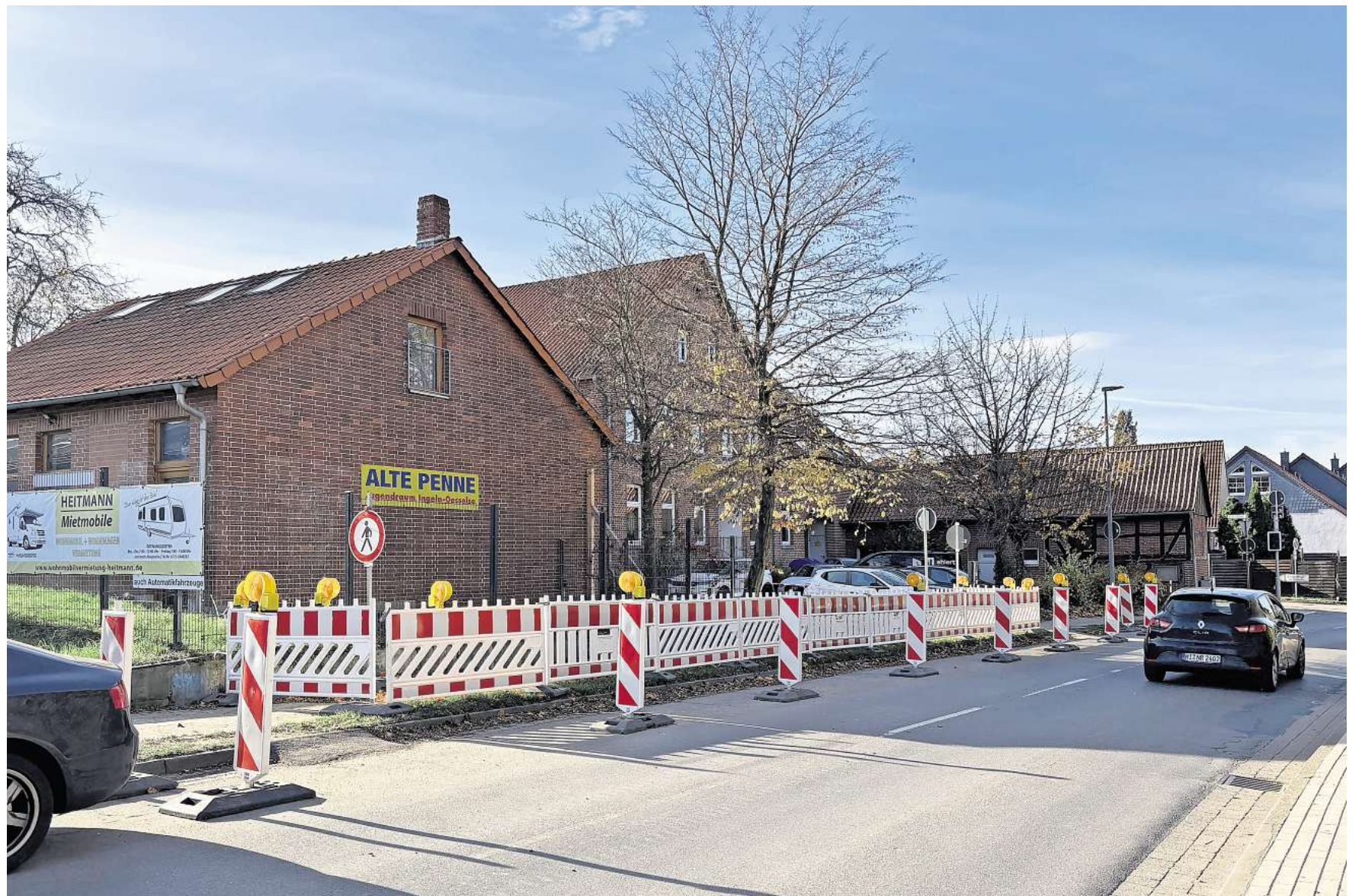
Mangelnde Standsicherheit: Der Jugendtreff Alte Penne neben der DRK-Kita in Ingeln-Oesselse wird zeitnah abgerissen.
