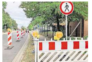
Sperrung: Ein Behelfsfußweg ist auf derselben Straßenseite direkt neben dem bestehenden Gehweg angelegt.
