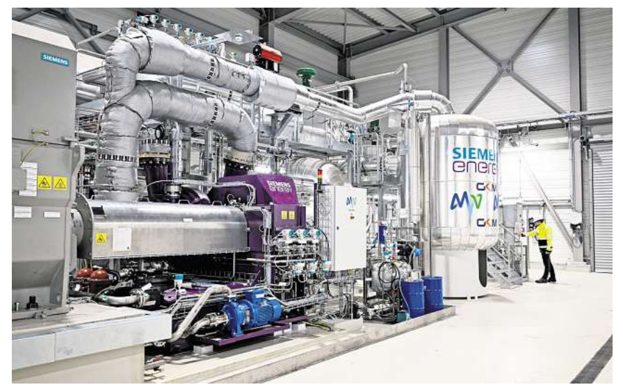
Flusswärmepumpe: Mit Wärme aus Flüssen sollen künftig Zehntausende Haushalte in Deutschland beheizt werden. Mancherorts wie etwa in Mannheim, Berlin oder Lemgo sind bereits Anlagen in Betrieb. Foto (Archiv): Uwe Anspach
