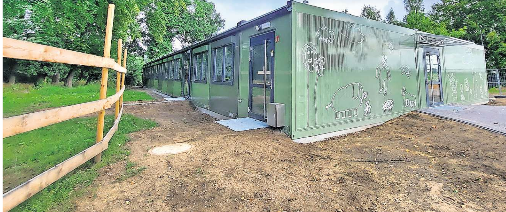
Das Containergebäude an der Grundschule Arnum: Dort sind zurzeit zwei Horträume, die Verwaltungsräume und das Lehrerzimmer untergebracht. Fotos (2): Torsten Lippelt
