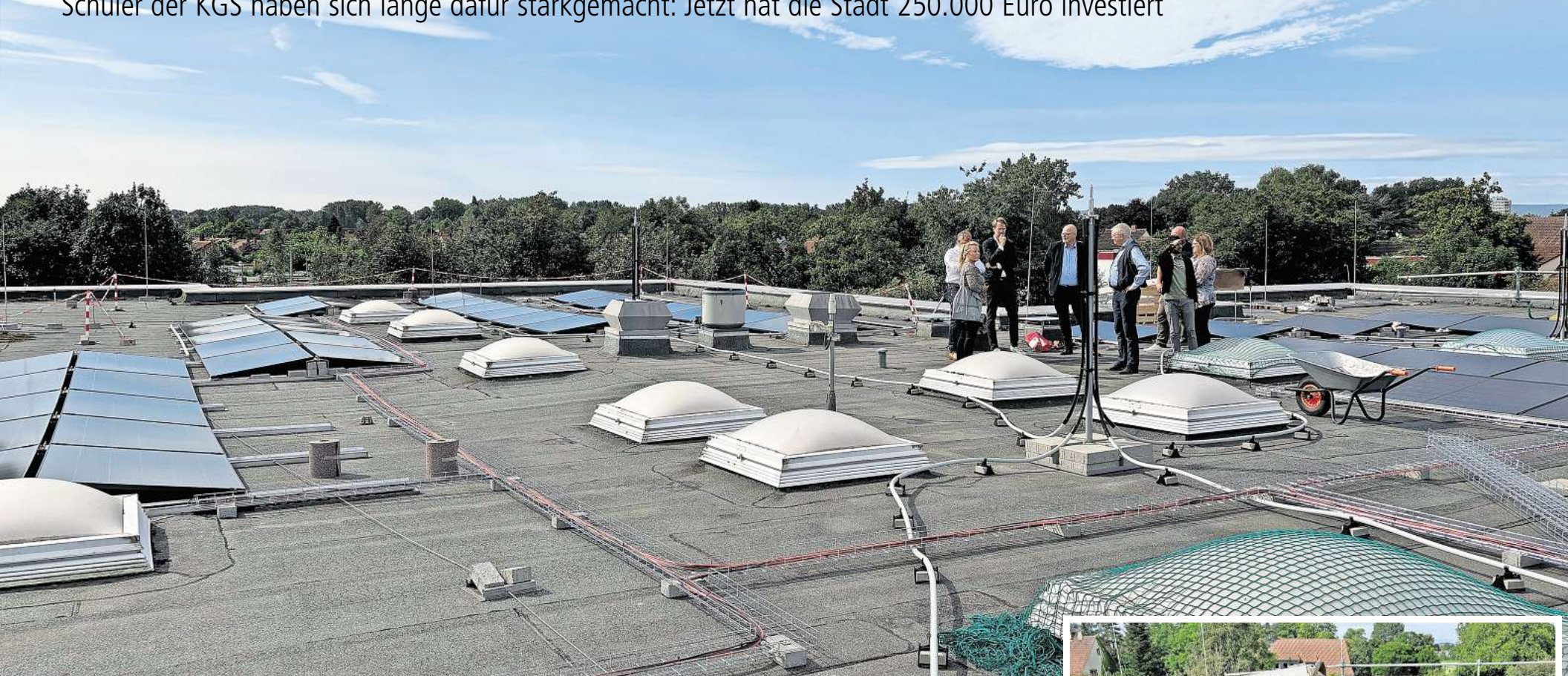
Das Dach des Oberstufengebäudes: Mehr als 130 Photovoltaikmodule sind dort jetzt installiert. Foto: Tobias Lehmann
