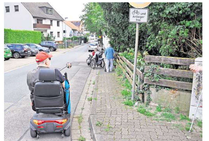
Nicht abgesenkte hohe Bordsteine, zu enge Wege, fehlende Hilfen für Blinde.
