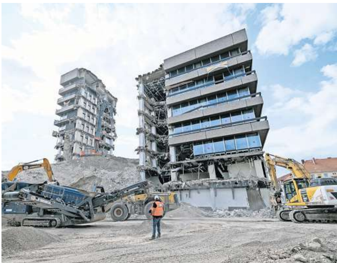
Vorne die Sortiermaschinen für Betonbruch, hinten der Longfront-Knabberbagger in Aktion: Der Abriss des ehemaligen Postscheckamts am Westrand der hannoverschen Innenstadt neigt sich dem Ende zu. Foto: Tim Schaarschmidt
