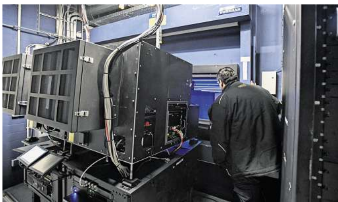
Astor-Kino bekommt einen neuen Saal mit besonderer Technik und Architektur, der Haustechniker Richi blickt in den Zuschauerraum.
