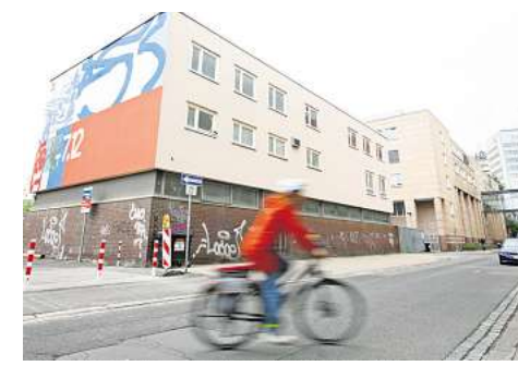
Das alte Depot der Straßenreinigung: An der Augustenstraße soll der neue Mecki 2.0 entstehen. Das Gebäude wird zudem aufgestockt und soll Übernachtungsplätze bieten.
