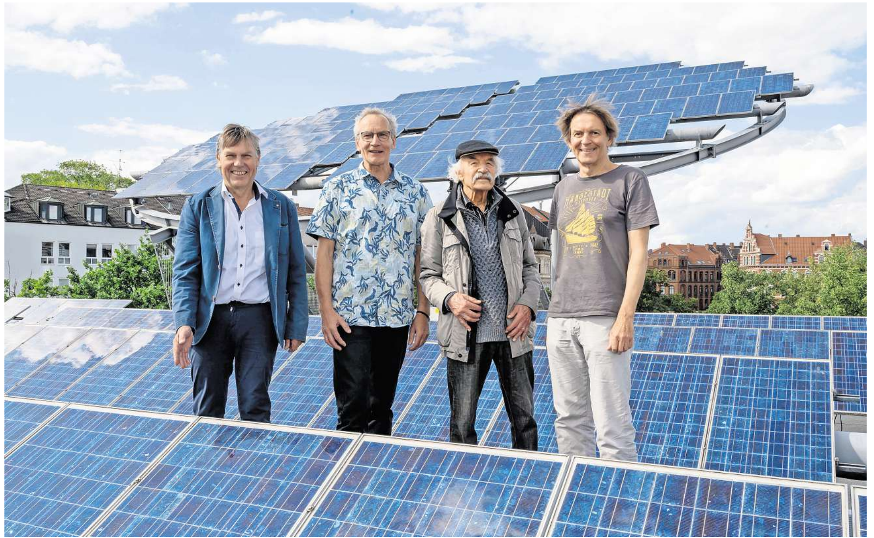
Solar-Pioniere (von links): Ulf Hansen-Röbbel von Corona Solar, Solarexperte Gerd Pommerien, Bauingenieur Bernhard Tokarz und der frühere Pavillon-Chef Uwe Kalwar auf dem Dach des Kulturzentrums am Weißekreuzplatz. Foto: Tobias Woelki
