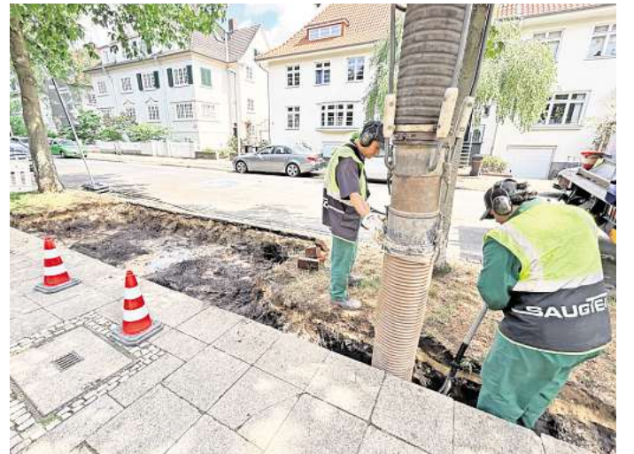
Um den Zustand der alten Straßenbäume zu verbessern, brechen Bodo Hornig und Sven Lampe von der Stadt mit einem Saugbagger die versiegelten Flächen um die Bäume herum auf und tauschen die alte Erde aus.
