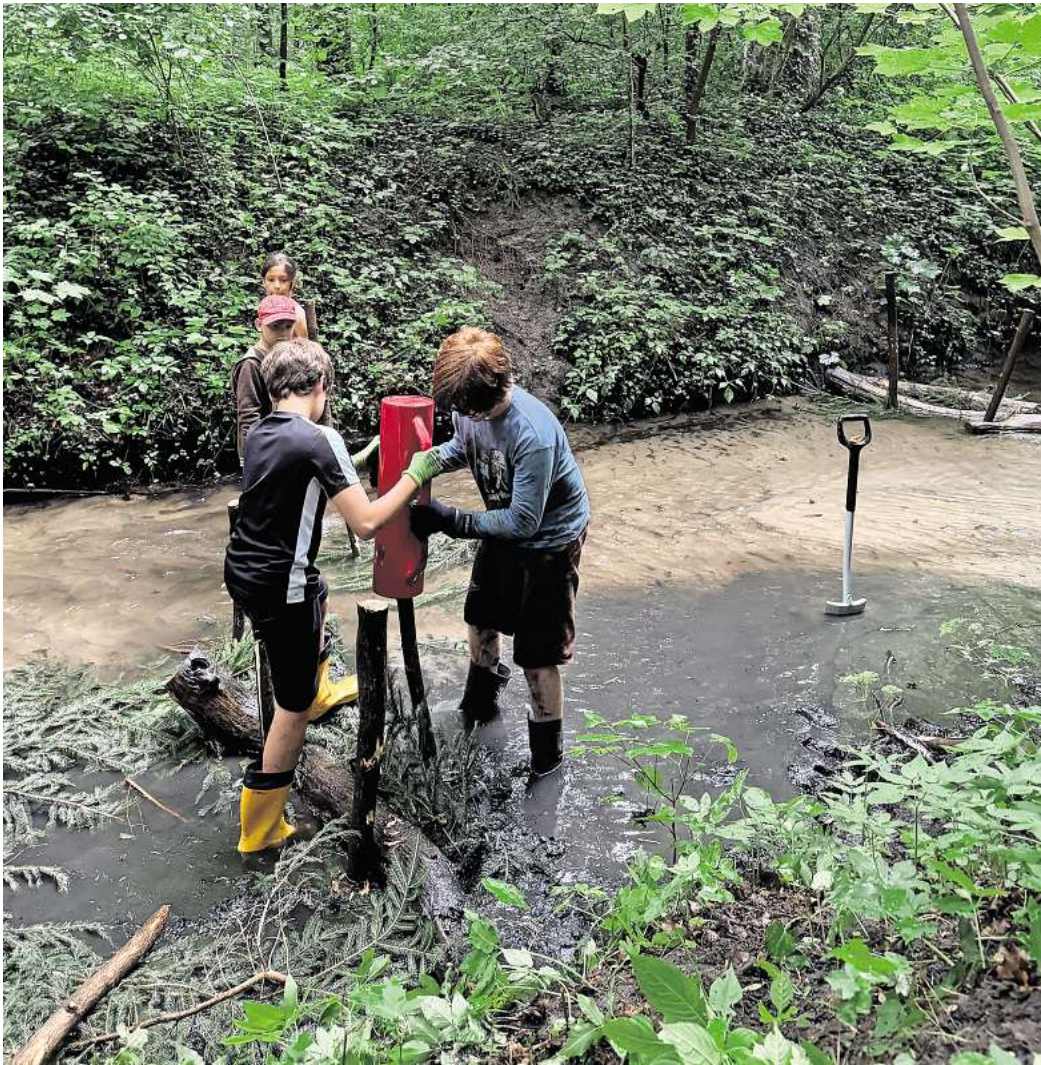
Kinder helfen bei der Renaturierung des Wietzegrabens.
