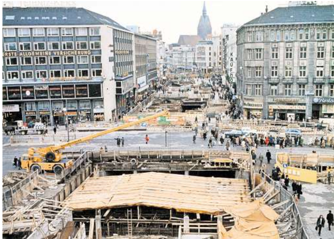
Die Bahnhofstraße Richtung Kröpcke im Jahr 1974: In der Baugru-be entstehen U-Bahn-Haltestelle und die Passerelle.
