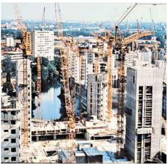
Ihme-Zentrum im Bau, 1973. Fotos: Historisches Museum Hannover
