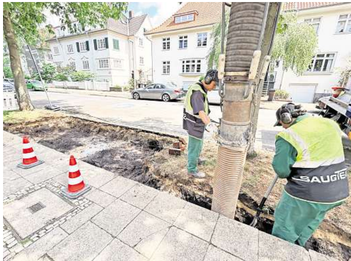
Um den Zustand der alten Straßenbäume zu verbessern, brechen Bodo Hornig und Sven Lampe von der Stadt mit einem Saugbagger die versiegelten Flächen um die Bäume herum auf und tauschen die alte Erde aus.
