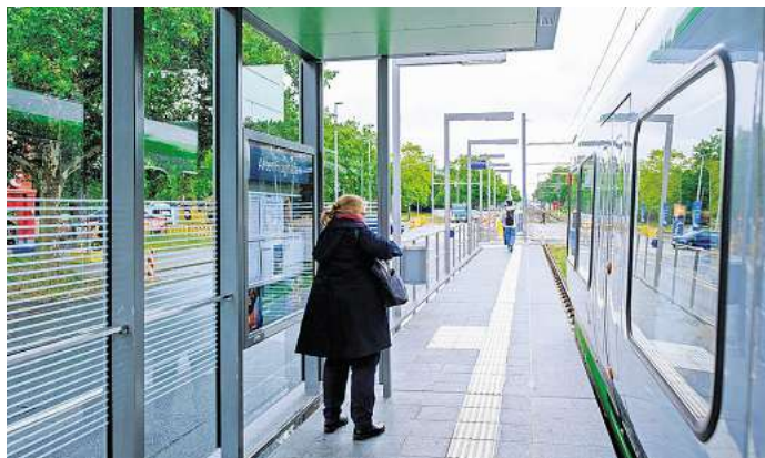
Hannover, Stadtbahn-Haltestelle Alter Flughafen (jüngster Hochbahnsteig). Foto: Betty Einhaus
