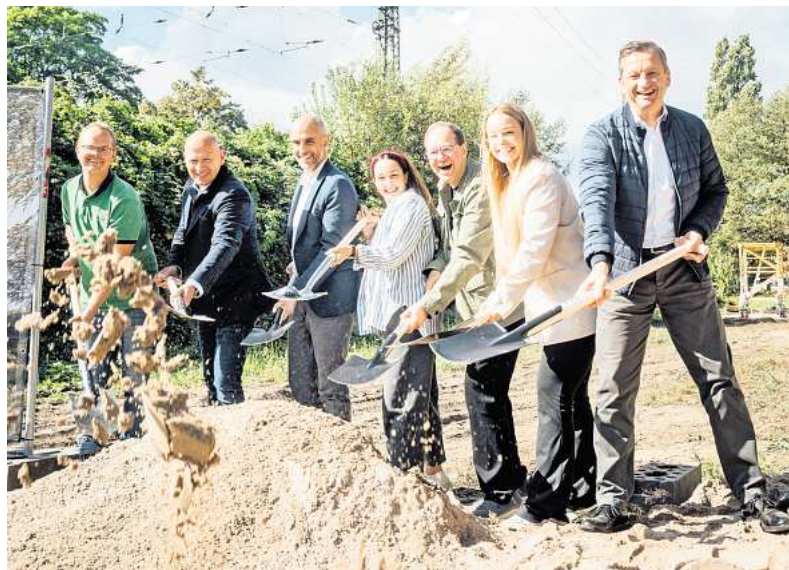
Spatenstich zum Neubau Bothe Lofts am Braunschweiger Platz. Von links: Lukas Schustereit (Geisler Bau), Markus Ringkamp (ri-Architekten), Oberbürgermeister Belit Onay, Barynia Bothe, Bezirksbürgermeister Ekkehard Meese, Anissa Bothe sowie Matthias Battefeld (Vorstand Hannoversche Volksbank). Foto: Christopher Busch
