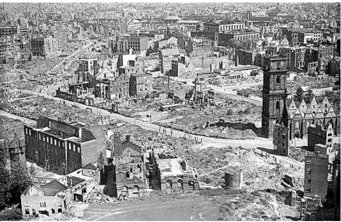
Zerstörtes Hannover-Mitte vom Rathausurm aus gesehen, Foto von Willy Bartmer, 1947. Quelle: LHH
