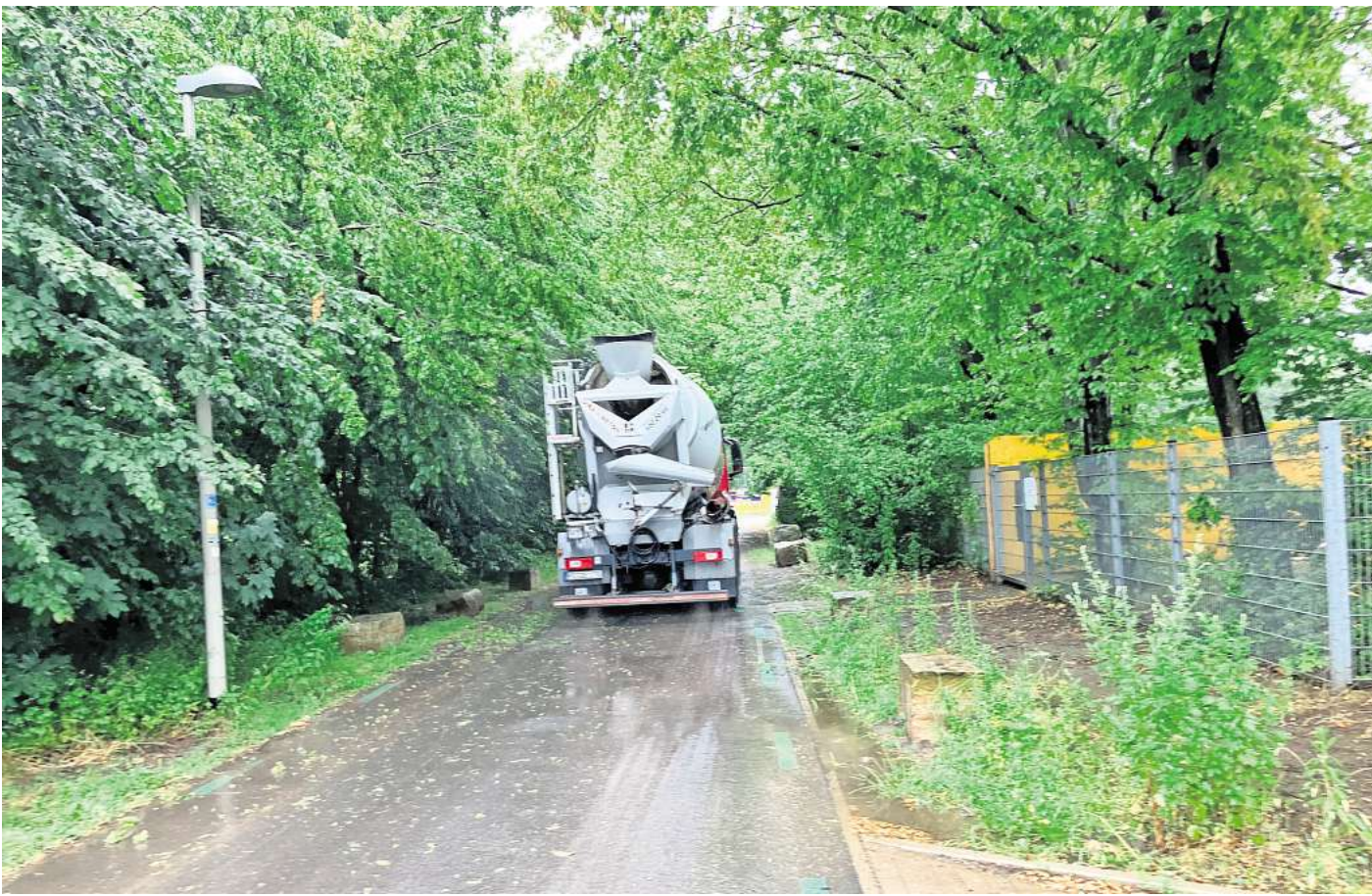
Bauarbeiten: Der enge Weg lässt aus Sicherheitsgründen keinen Radverkehr zu. Foto: LHH
