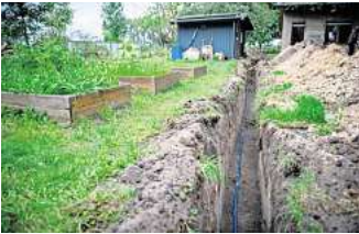
Vorsicht bei Tiefbauarbeiten! Foto: Zacharie Scheurer/dpa
