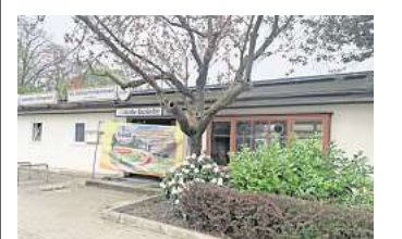
Die Gaststätte 11 A des VfL Eintracht wird grundlegend saniert. Foto: VfL Eintracht
