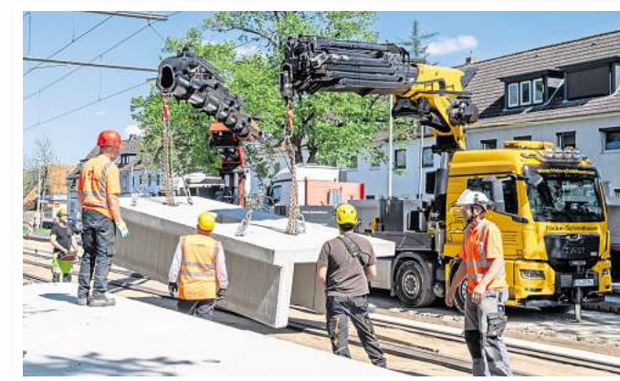
Mehr Hochbahnsteige: In Bothfeld errichten Arbeiter den nächsten barrierefreien Zugang für die Stadtbahn. Foto: Tobias Woelki
