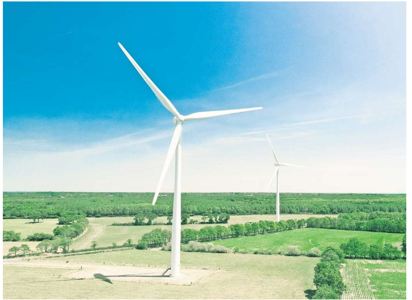
Windenergie-Verbände warnen vor einer politischen Kehrtwende beim Ausbau erneuerbarer Energien, die letztlich aufgrund unrealistischer Bedarfsschätzungen der gesamten Wirtschaft Schaden würde. Symbolfoto: Thomas Reaubourg / Unsplash
