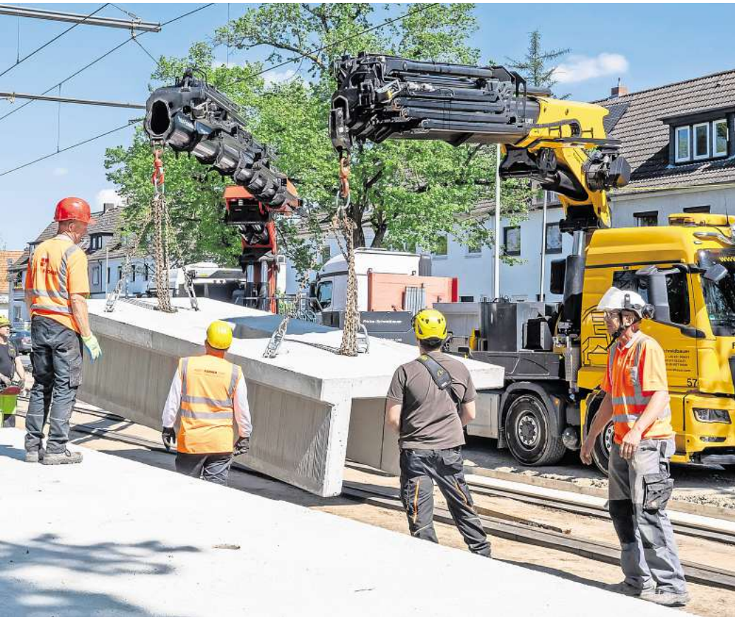
Zentimetergenaues Rangieren: Arbeiter setzen die tonnenschweren Betonelemente für den Hochbahnsteig am Stadtfriedhof Bothfeld. Mithilfe von zwei Autoauslegekränen müssen die Elemente vorsichtig unter den Stromleitungen hindurchgezielt werden.
