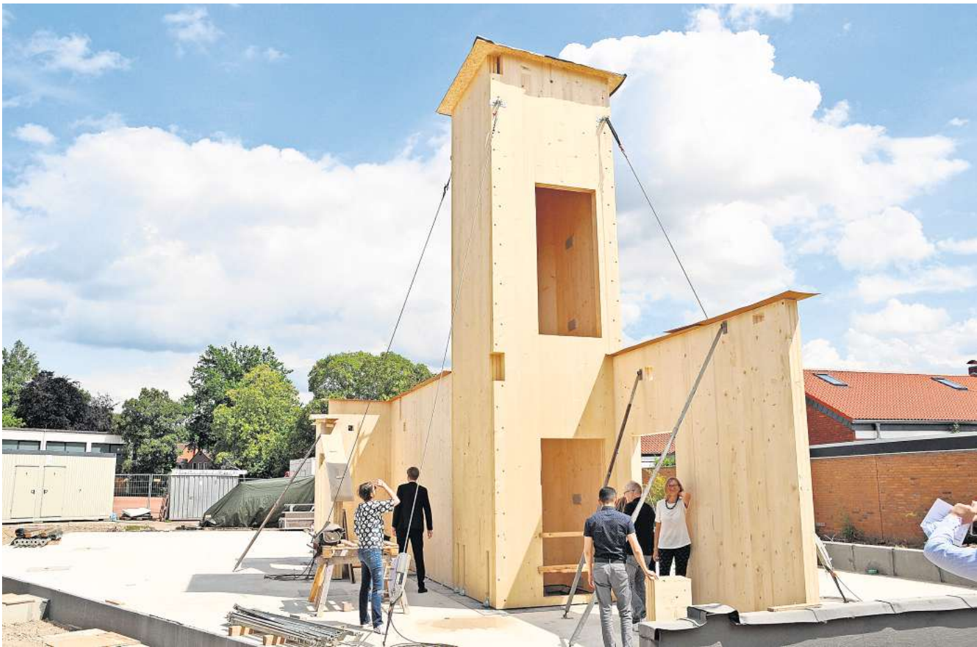
Sieht so aus, wird aber kein Schlauchturm der Feuerwehr: In diesem Schacht fährt später ein Lift.
