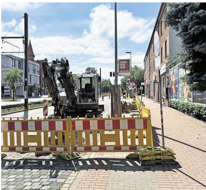
Umbau: Die Veloroute 8 in Laatzen soll sicherer werden.
