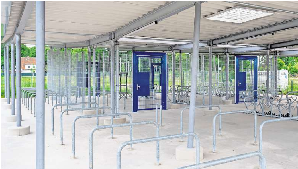
Die Überdachung ist ein umweltfreundliches Gründach, an den Fahrradbügeln, die größtenteils beidseitig nutzbar sind, ist Platz für rund 140 Fahrräder.
