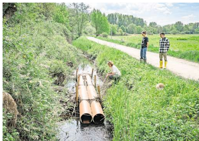
Die Biologin und Bibermanagerin Kristine Gilster (von links) sowie die ÖSML-Praktikanten Lucia Stiebler und Hannes Enge messen den Wasserstand an den Drainagerohren in der Bruchriede.
