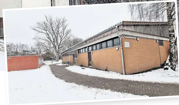
Neubau geplant: Die von Grundschule und Kita genutzte Turnhalle - hier neben den "Schlösschen" genannten provisorischen Klassenzimmern - soll einer neuen Mehrzweckhalle weichen. Fotos (2): Johannes Dorndorf
