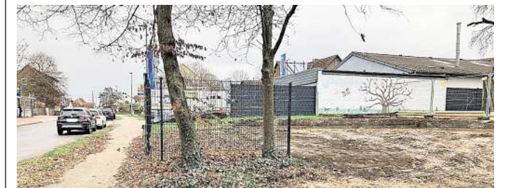
Neue Freifläche: Der einstige Schulbau „Alte Penne“ in Ingeln-Oesselse, der die letzten Jahrzehnte als Jugendtreff diente, wurde Ende November abgerissen. Foto: Stadt Laatzen
