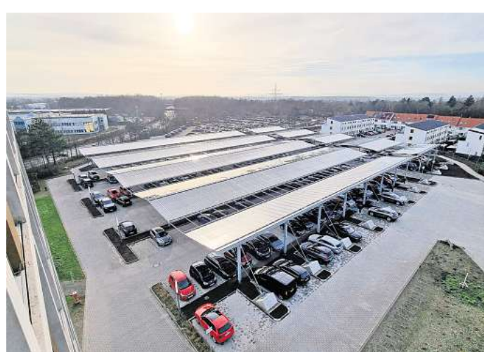
Einzigartige Konstruktion: 1752 Solarmodule überspannen neuerdings 300 der Parkplätze an der Deutschen Rentenversicherung. Fotos: Johannes Dorndorf
