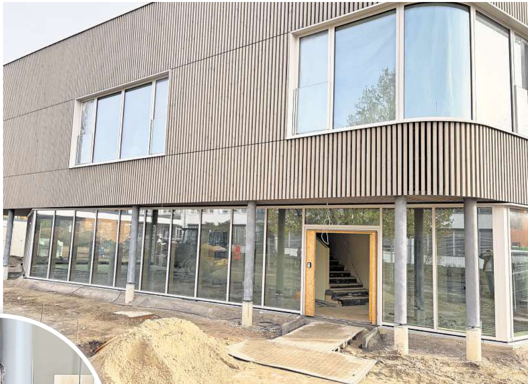
Soll 2026 fertig werden: Die Mensa der Grundschule Hemmingen-Westerfeld. Fotos (2): Tobias Lehmann
