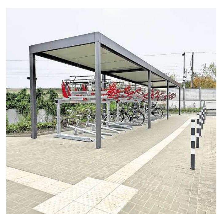
Platz für 84 Fahrräder: Die drei doppelstöckigen Anlagen an der Koldinger Straße sowie der Ostseite des Rethener Bahnhofs sind ab sofort zu nutzen. Foto: Daniel Junker
