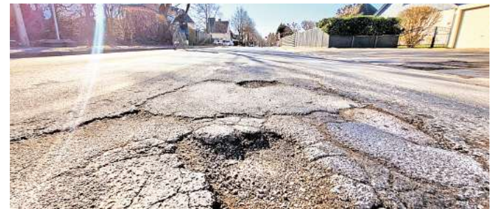
Auf der L389 zwischen der alten B3 und Ohlendorf zeigen sich Risse und Schlaglöcher im Straßenbelag.
